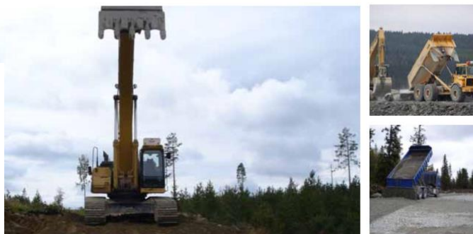
Frisks entreprenad företag i Hede som bland annat byggt vägar och gjort andra markarbeten för vindkraften i på
