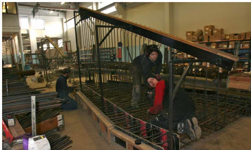
Torbjörn Olsson, Markus Thors och Marcus Norlén arbetar med armering som används vid gjutning av en bit av ett fundament till vindkraftsparken i Sjisjka i Norrbotten.
