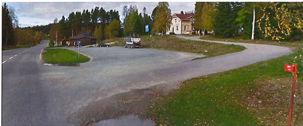
Bild på planområdet och infartsväg till byggnader nordost om planområdet (Källa: Google Earth 2017-03-03)
