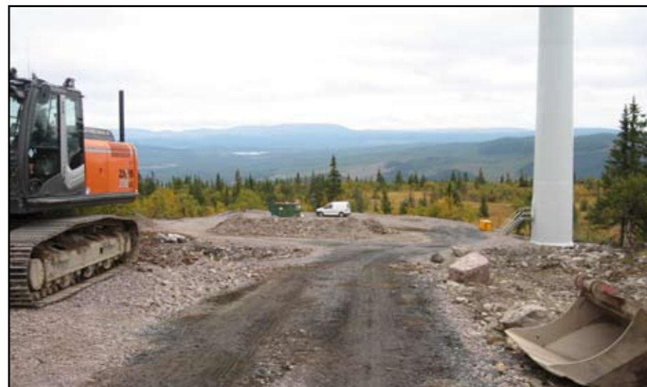
Kranuppställningsplats till ett av vindkraftverken på Bliekevare, i Dorotea kommun.
