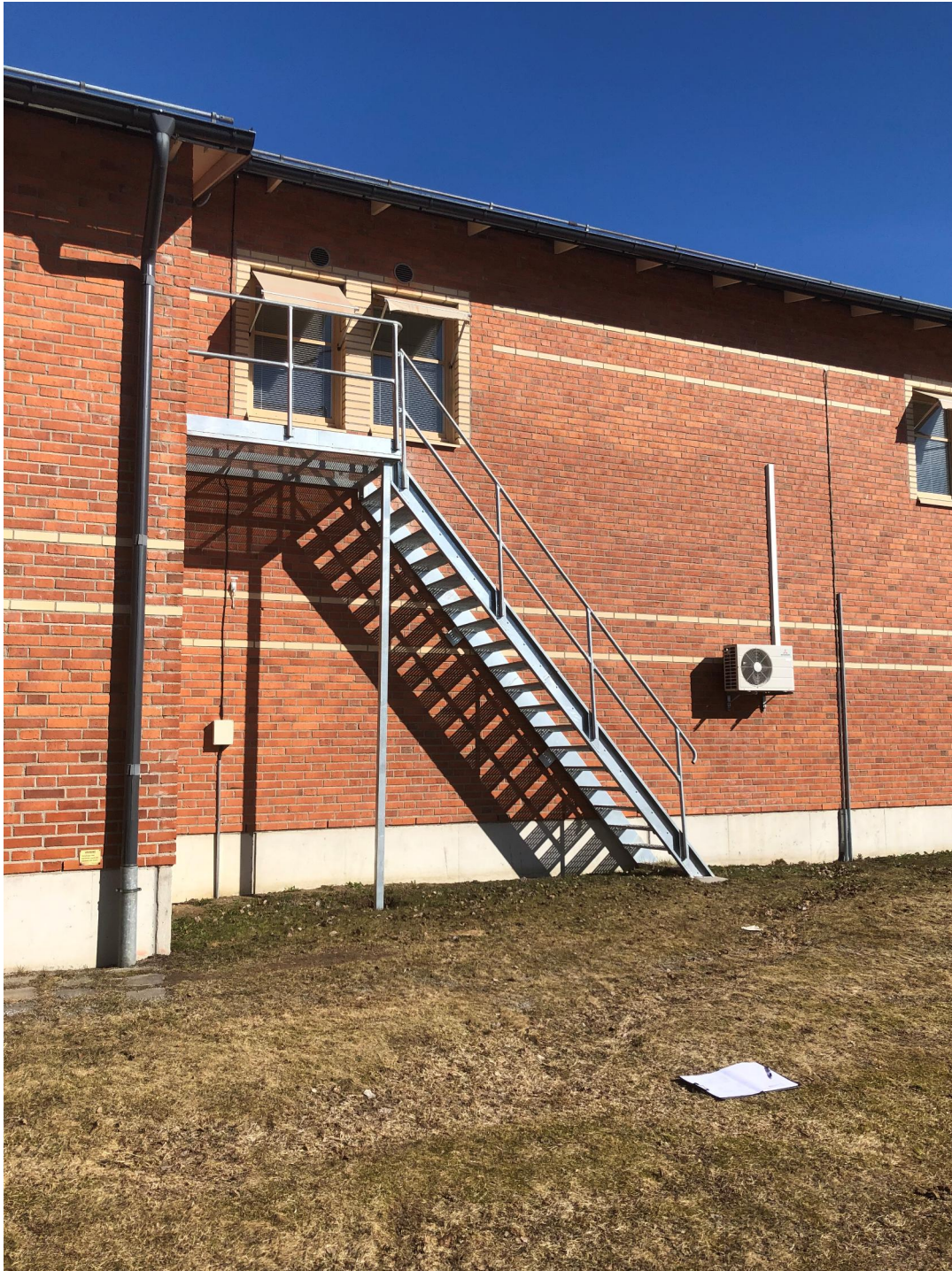
Fasad mot söder med utrymningstrappa
