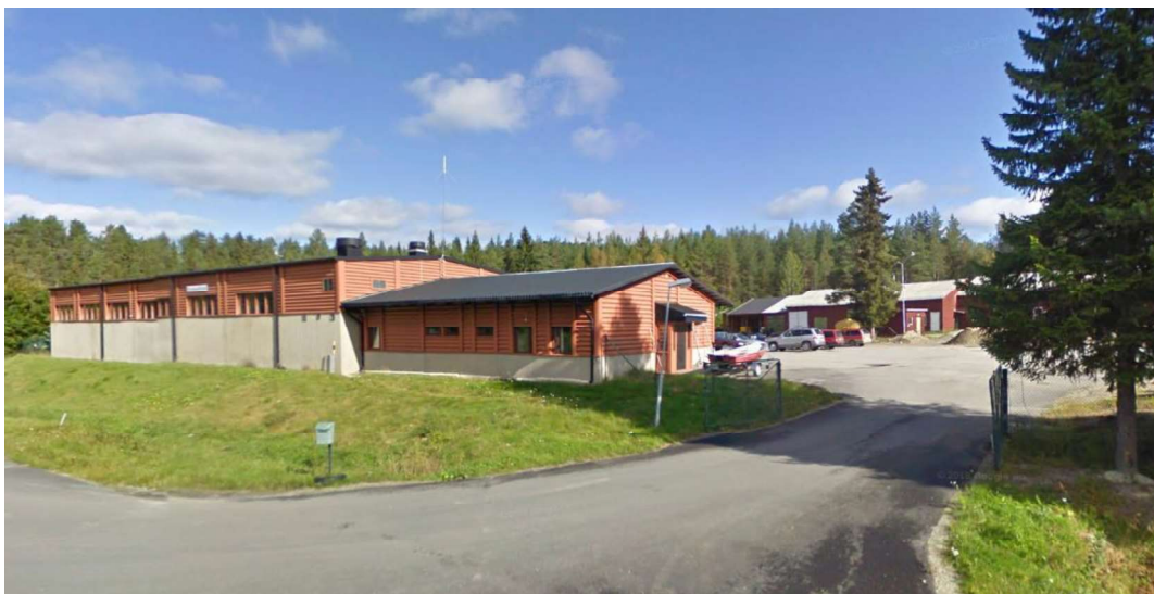
Figur 6. Byggnader på intilliggande fastighet Förrådet 1.
